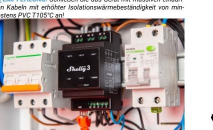
Bevor Sie mit der Installation/Montage des Geräts beginnen, prüfen Sie, ob die Leitungsschutzschalter (Sicherungen) ausgeschaltet sind und keine Spannung an den Klemmen anliegt. Dies kann mit einem Phasenprüfer oder Multimeter erfolgen. Wenn Sie sicher sind, dass keine Spannung anliegt, können Sie mit dem Anschluss der Kabel fortfahren!
